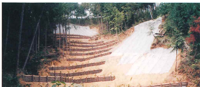
間伐材を使った災害復旧地
