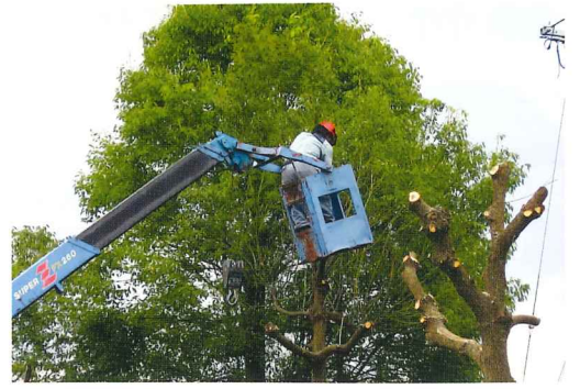
配電線に係る支障木伐採作業
