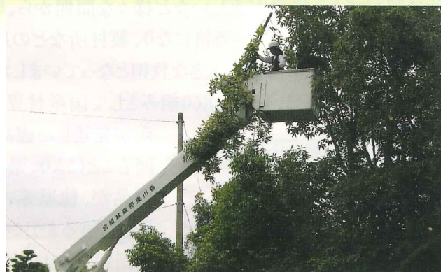
市道法面樹木伐採(高松市牟礼町)
