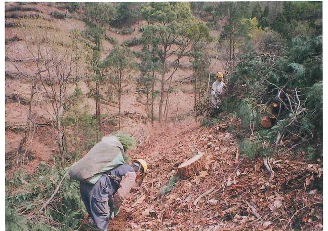
植栽作業の様子 (東かがわ市白鳥地内)
