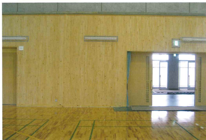
三木中学校体育館
